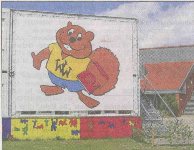
Die Wallschule hat weiterhin zwei mobile Klassenräume.
