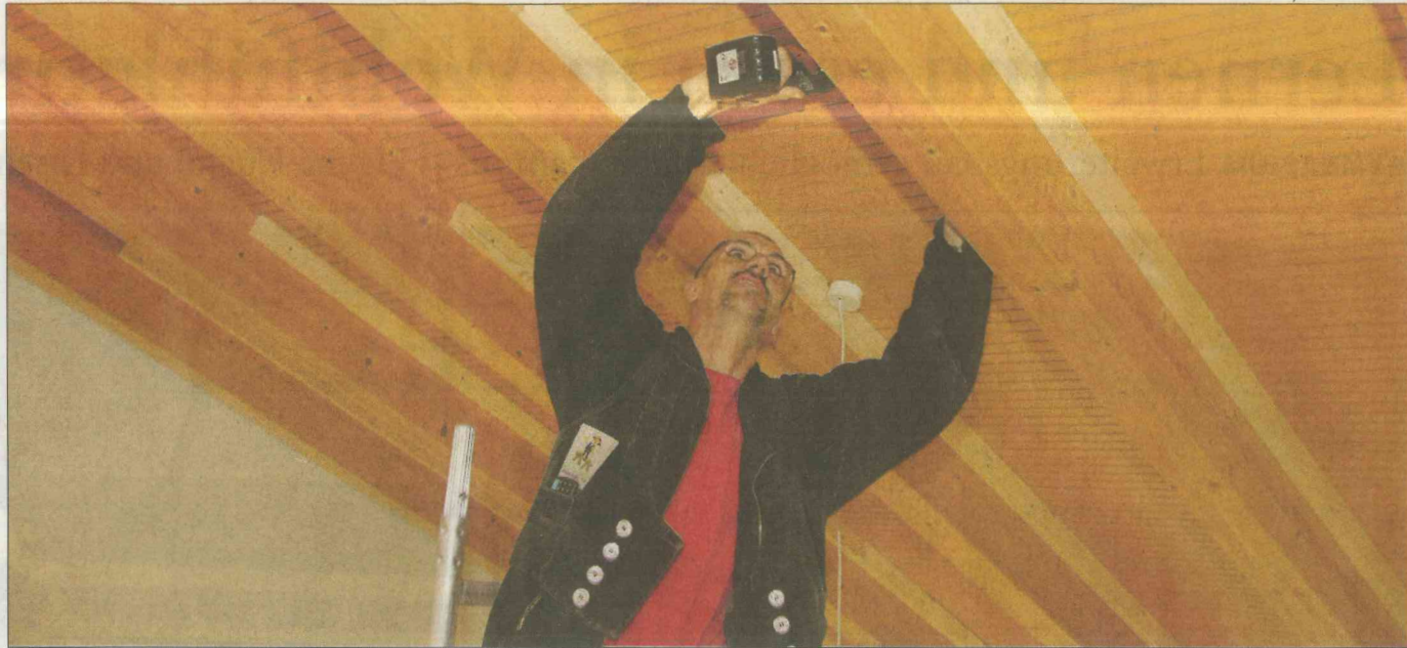
Arbeiten an der Decke der Wallschule: Zimmermann Detlef Lehnhof befestigt Kanthölzer.
